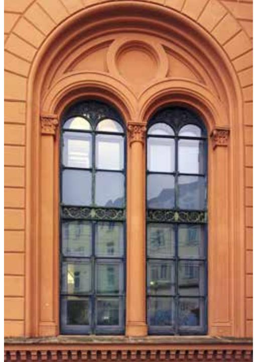
noch sehr aufwändig sind jedoch die Falze zwischen Flügeln und Rahmen, die oft als Keil-, Kneif- oder S-Falz gearbeitet sind. An den eigentlichen Verschlussmechanismen hingegen ändert sich nichts Wesentliches. Charakteristisch ist jedoch, dass Beschlagteile und auch Baskülever-schlüsse trotz gleicher Technik nun gerne verdeckt eingebaut und in die Flügelrahmen eingelassen werden.
