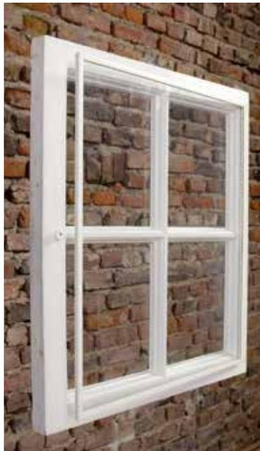
Beim Einkleben der dünnen Isoliergläser übernimmt der Kleber und der Scheibenrandverbund vorübergehend die Wiederherstellung der Stabilität der Konstruktion, welche durch den Materialverlust von Holz, Kitt und Glas verloren gegangen ist – bis irgendwann der Austausch wegen Funktionsverlust bzw. „Blind werden“ der Isolierscheibe wieder notwendig wird, usw. Durch die Verluste wird hier besonders deutlich, dass diese Vorgehensweise mit der Charta von Venedig nicht vereinbar ist.
