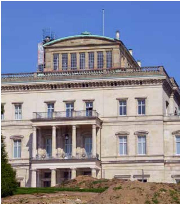
bezeichnet werden. Das technische Herzstück der Anlage lag im eindrucksvollen Belvedere des Hauses, deren Lüftungsanlage an die Aufbauten eines Schiffes erinnert. Die Anlage funktionierte allerdings nicht ohne Schwierigkeiten und im Jahr 1914 wurde das Haus an eine moderne Dampf-Fernheizung angeschlossen.
